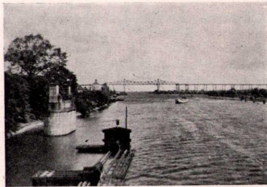
The Kiel Canal at Rendsburg.
